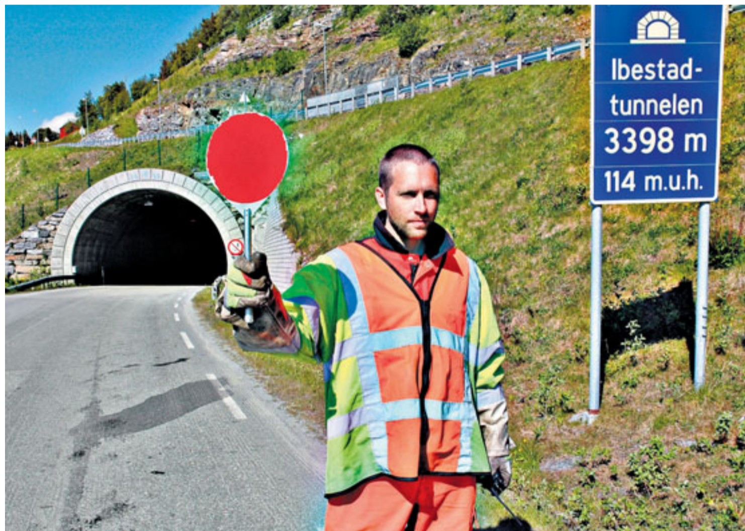
STOPP: Leif Ådne Pettersen stoppet trafikken ved Ibestadtunnelen, der det foregår arbeid med opprensning. Foto: Kjell Solbakken
