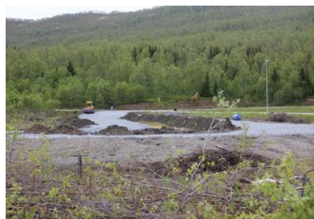
Nytraseen: Her er arbeidet i gang med den nye traseen som skal bygges på banen på Aspelund. FOTO: MATHIAS BROBAKK
